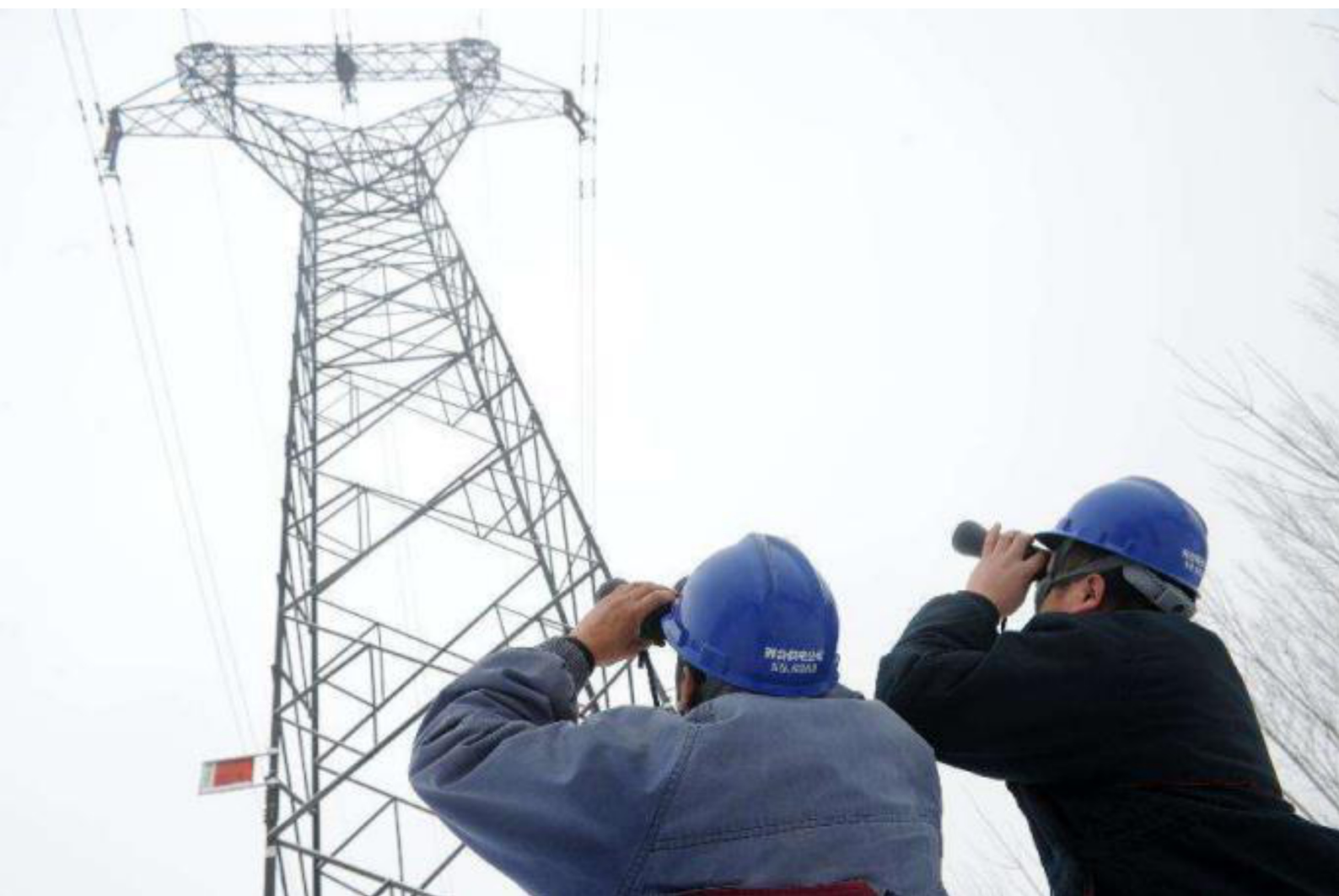
Рисунок 1 - Традиционное обследование ЛЭП
