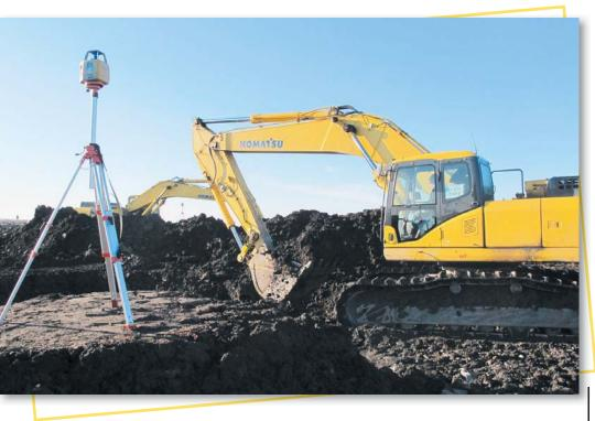
системой выступает компьютер GX-60, использующийся так же в 3D системах для бульдозеров и грейдеров. Кабельное соединение всегда было надёжнее беспроводного, поэтому использовать такую конфигурацию лучше в тех случаях, где необходимо надёжное соединение. Дополнительно к стандартной комплектации в систему могут быть включены датчики второй стрелы и наклонного ковша, компас, лазерный приёмник
